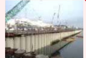
海側遮水壁 鋼管矢板打設完了状況
