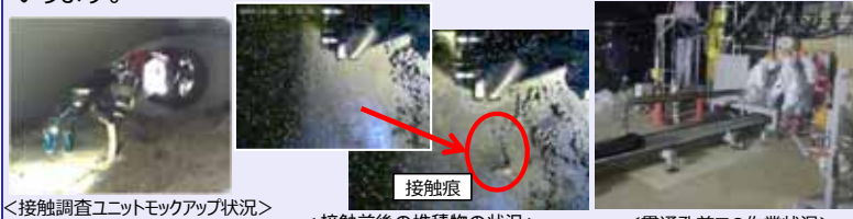
<接触調査ユニットモックアップ状況>
