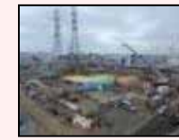
H1東エリア解体後の様子
