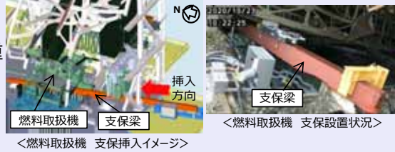
<燃料取扱機 支保挿入イメージ>
