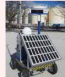
線量率モニタの設置状況
