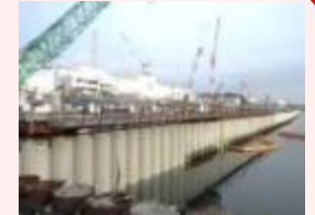
海側遮水壁 鋼管矢板打設完了状況
