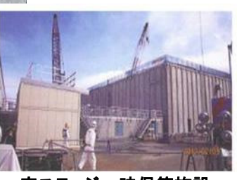
廃スラッジ一時保管施設
