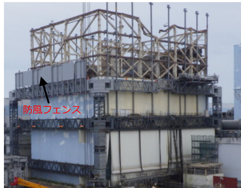
防風フェンス設置状況(11月9日撮影)
