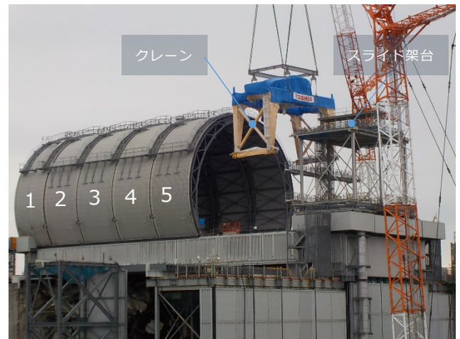
3号機原子炉建屋オペフロ全景 (11月20日時点)
