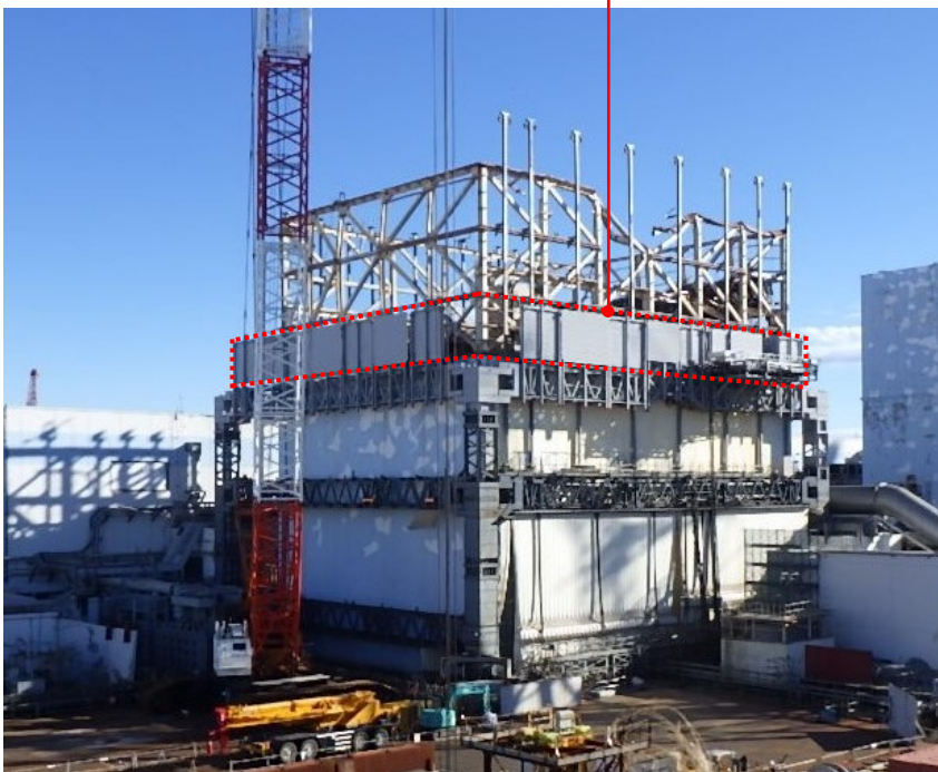
防風フェンス取付状況 撮影：H29.11.28
