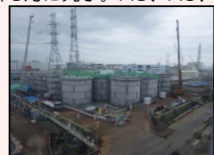
H1東エリア解体開始時の様子
