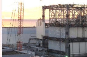
<壁パネル取り外し状況>
