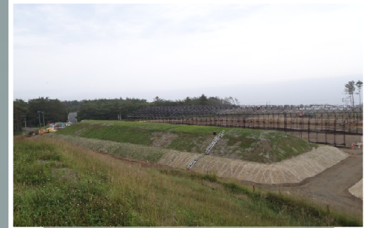
覆土式一時保管施設
