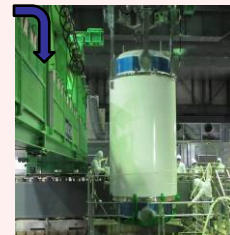
燃料取り出し状況
