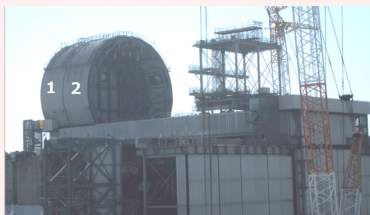
ドーム屋根設置状況（9/26撮影）
