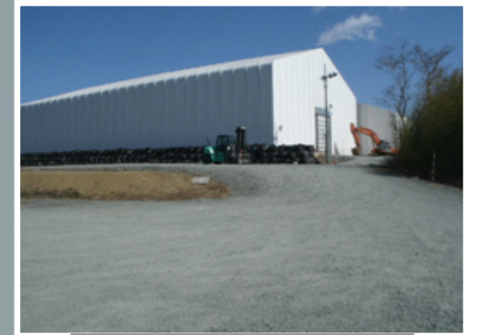
瓦礫保管テント
