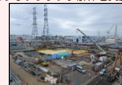
H1東エリア解体後の様子
