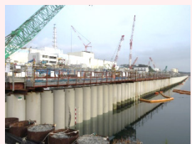
海側遮水壁 鋼管矢板打設完了状況
