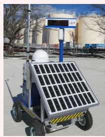
線量率モニタの設置状況
