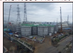
H1東エリア解体開始時の様子
