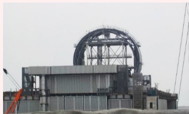
燃料取り出し用カバー設置状況 (2017/8/5撮影)
