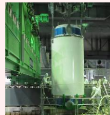
燃料取り出し状況
