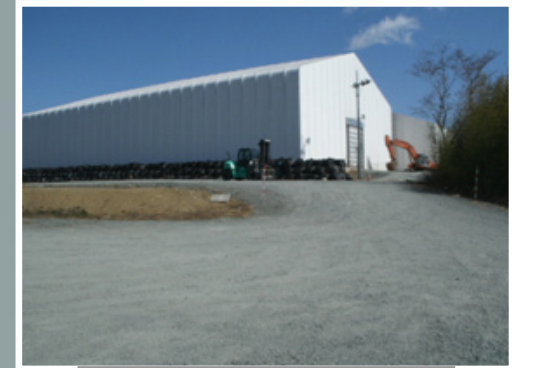
瓦礫保管テント
