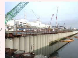
海側遮水壁 鋼管矢板打設完了状況
