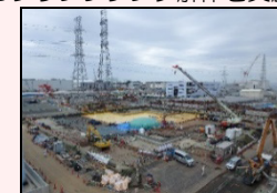
H1東エリア解体後の様子
