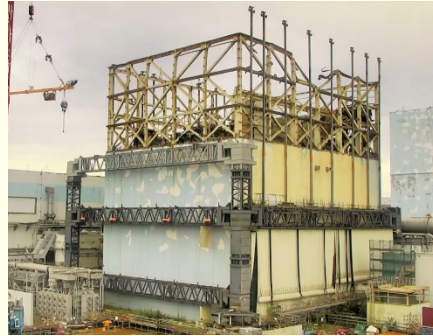
1号機建屋カバー ＜北側柱・梁取付け状況＞ (8/31北西側より撮影)
