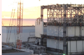
<壁パネル取り外し状況>
