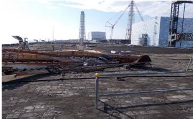
【施工前】1号機T/B屋上
