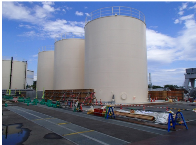
一時貯水タンク増設
