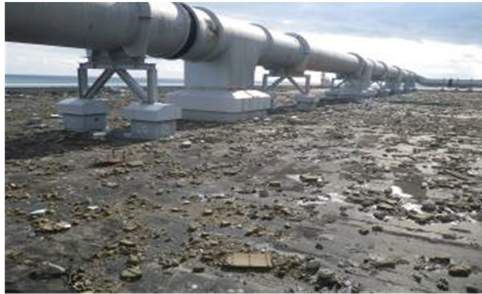
【施工前】4号機T/B屋上
