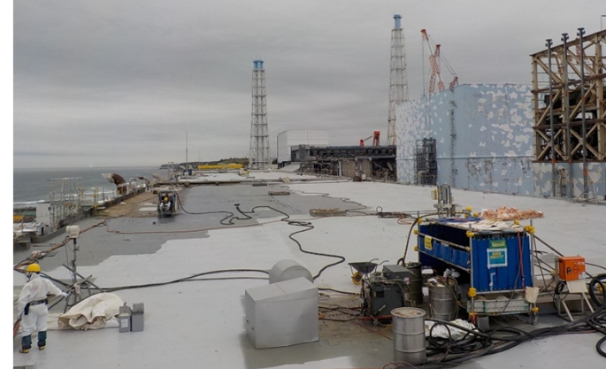
【現況】1号機T/B屋上
