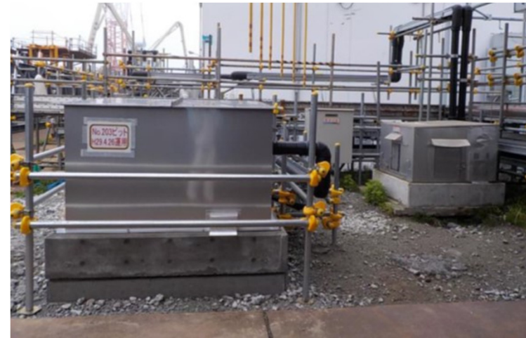
新設ピット増強（順次施工中）
