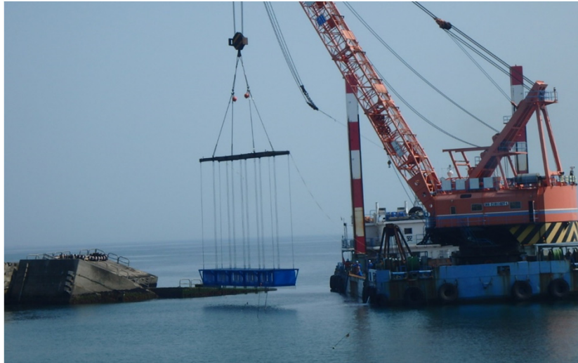
設置状況（作業全景）
