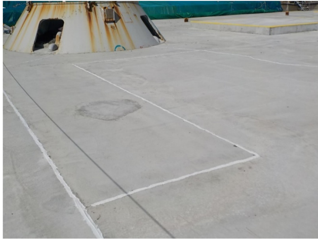
4m盤フェーシング継手止水
