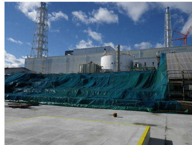
7.5m盤法面シート架け
