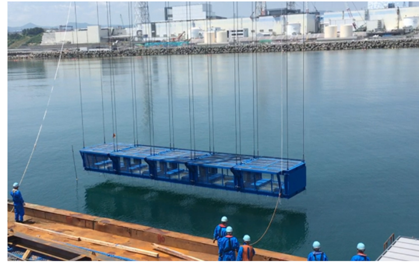
設置状況（作業近景）
