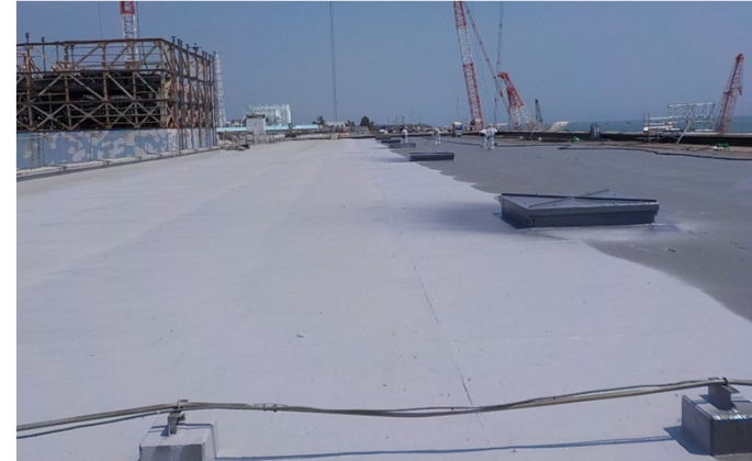
【現況】2号機T/B屋上
