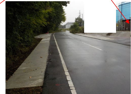
道路の西側路肩部分
