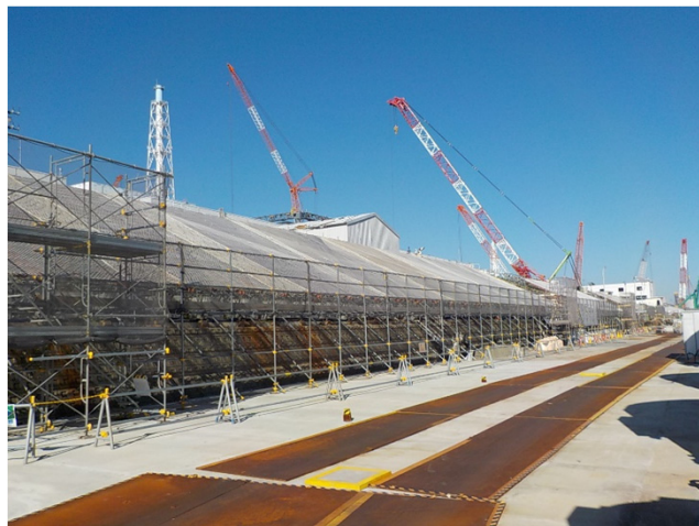
7.5m盤法面屋根架け
