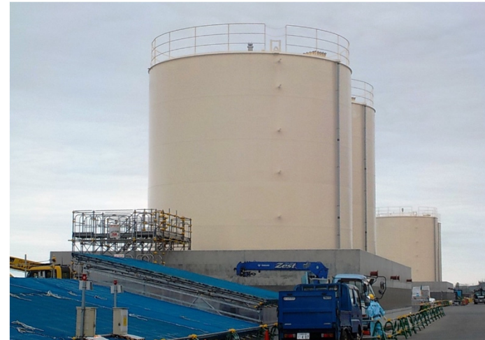
集水タンク増設（2号機除塵機撤去後，タンク据え付け）
