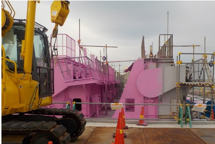
集水タンク増設（2号機除塵機撤去前）
