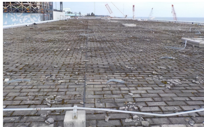
【施工前】2号機T/B屋上
