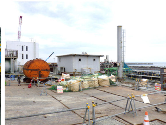
フェーシングにむけた ヤードの整備状況 2017.4.22撮影
