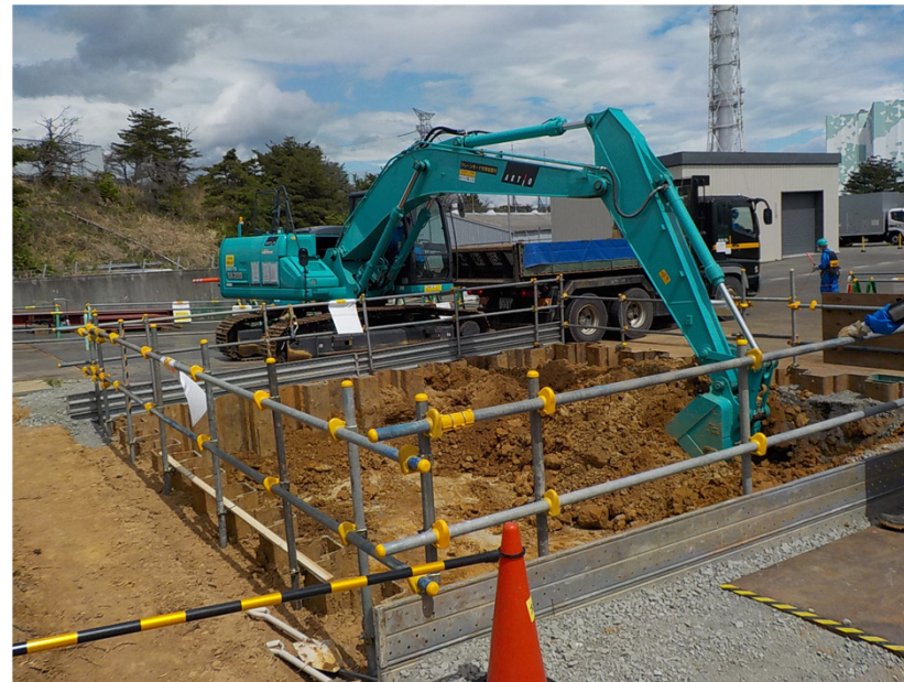
工事の状況（推進立坑掘削：5月11日現在）
