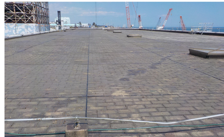
【現況】2号機T/B屋根（簡易防水工事中） : 0.5mSv/h
