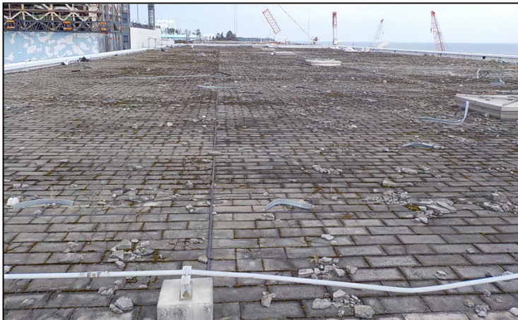
【施工前】2号機T/B屋根 : 0.7mSv/h
