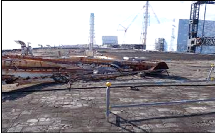
【施工前】1号機T/B屋根 : 1.2mSv/h
