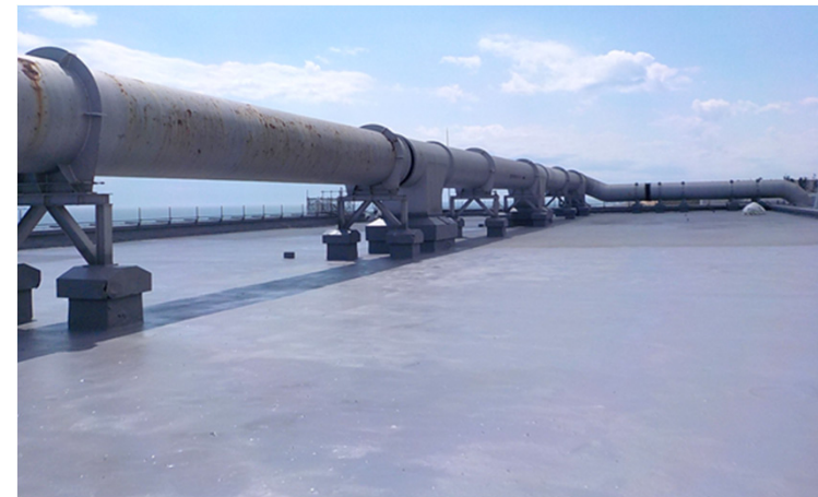
【現況】4号機T/B屋根（防水工事中） : 0.2mSv/h
