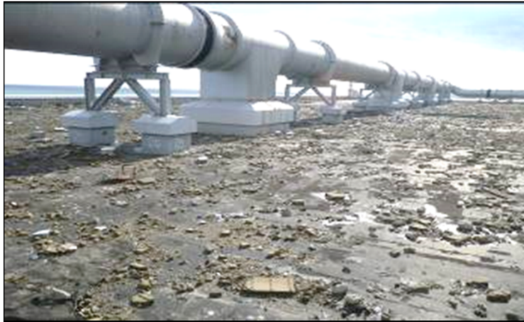
【施工前】4号機T/B屋根 : 0.5mSv/h
