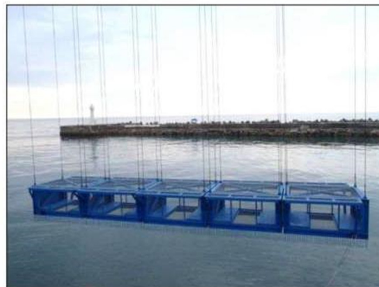
ブロックフェンス設置時の様子
