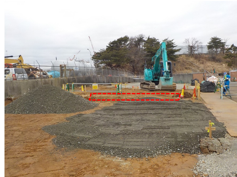
工事の状況（推進立坑周辺碎石敷均し） ※ [red dashed box] 推進立坑掘削箇所
