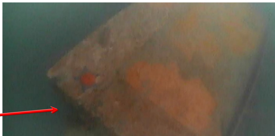
海中のブロックフェンス(底面部が水面方向を向いている)
