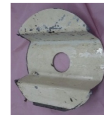
③デッキプレート塗膜B 天井側 (1RB-OP-D2-1)
