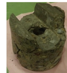
②コンクリートコアB 天井側 (1RB-OP-C2-2)
