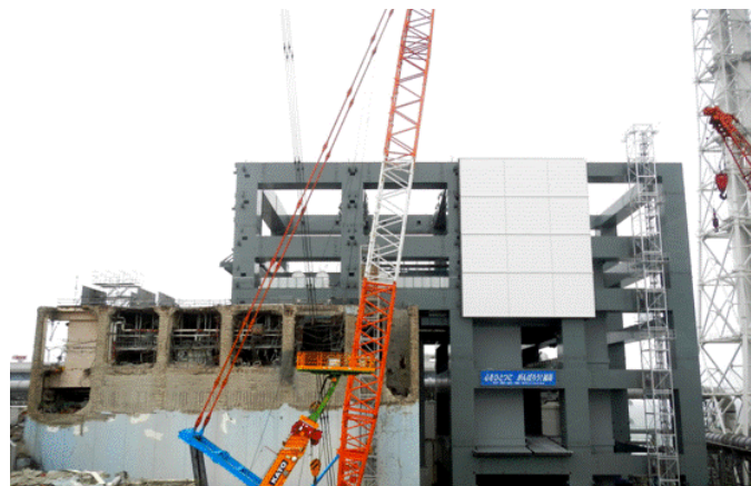
鉄骨建方完了（5/29）
