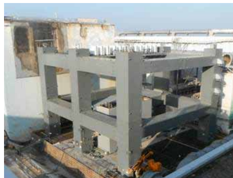
第2節部分鉄骨建方終了（2/28）
