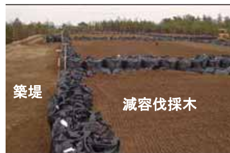
伐採木搬入状況 (2/19撮影)
