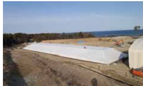
ガレキの受入れ状況 (2槽目：2/26撮影)
