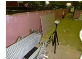
結合燃料棒引き抜き状況(一部)
