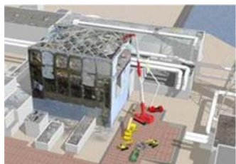
原子炉建屋上部のガレキ撤去
