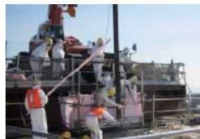
4号機使用済燃料プールの新燃料取出し作業(7/18, 19)
