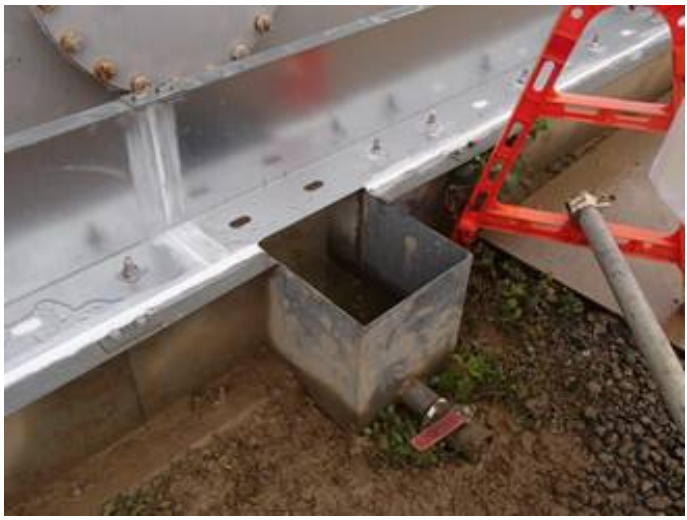
排水柵 閉塞前(外側)
