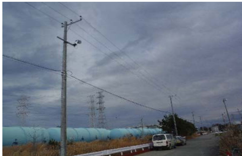
区間-D 配電線、照明設置状況(H1-D)
