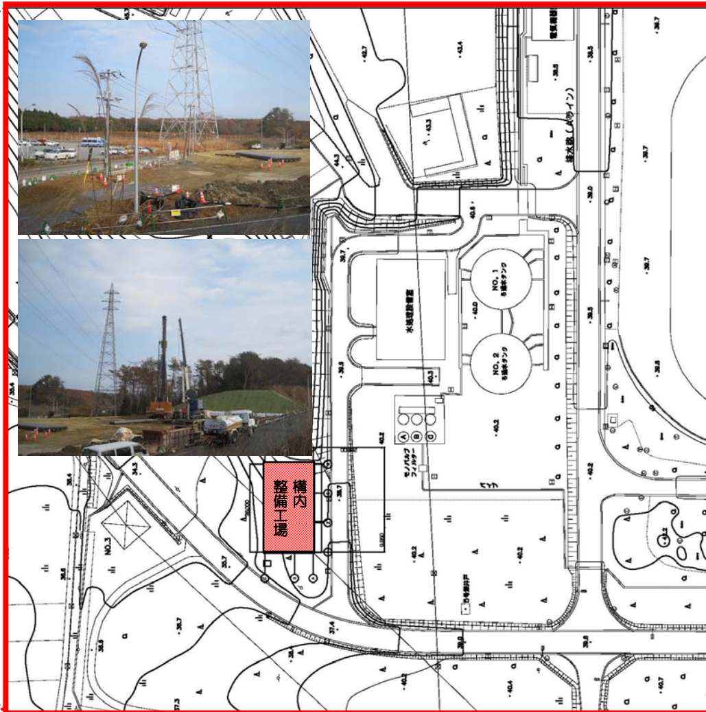
工事風景：2013.12.4現在の状況
