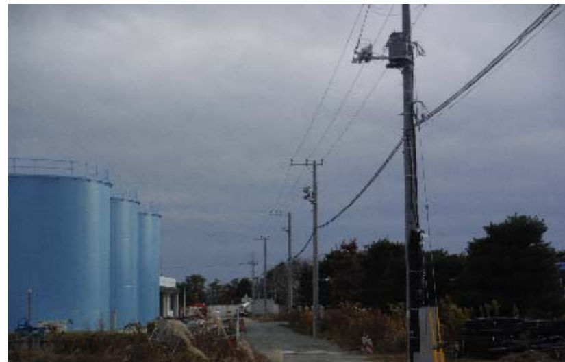
区間-E 配電線、照明設置状況(H8)
