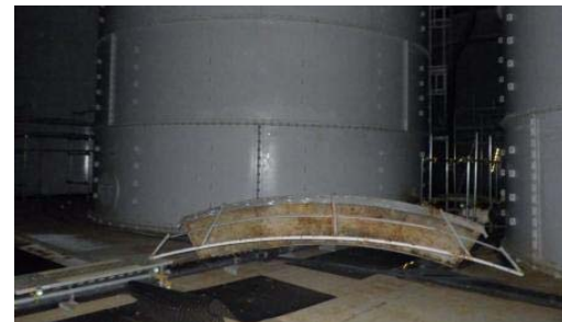
フランジタンク歩廊落下
