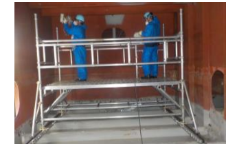
内部除染状況
