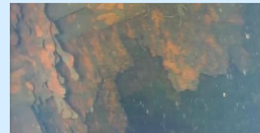
ペDESTAL内側の状況
