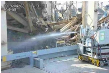
局所散水状況
