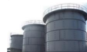
フランジ型タンク
