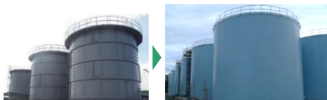
フランジ型タンク
