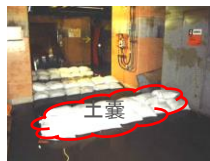
高温焼却炉建屋の土嚢状態 (設置時)
