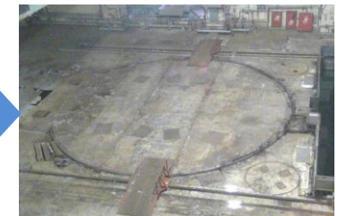
撮影方向②片付け作業後
