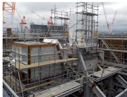
主要機器設置状況 (二次燃焼器、排ガス冷却器)
