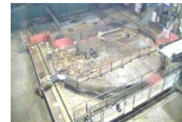
撮影方向②片付け作業前
