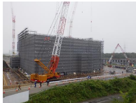
工事エリア全景
