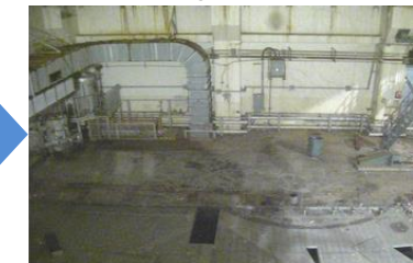
撮影方向③片付け作業後
