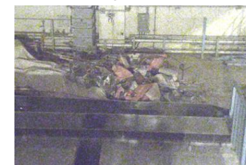
撮影方向③片付け作業前
