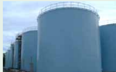
溶接型タンク
