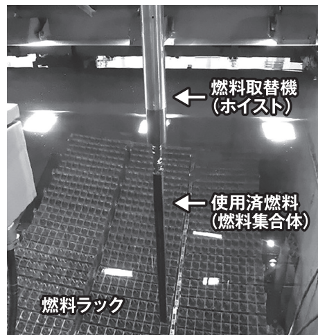
使用済燃料プールから燃料を取り出す様子 (撮影日:2025年7月23日)
