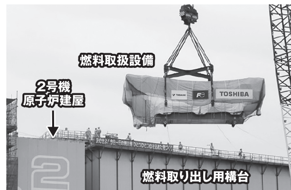
大型クレーンを使って燃料取扱設備を構台へ搬入している様子(2025年5月30日撮影)
