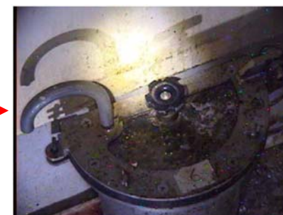
機器ファンネル
