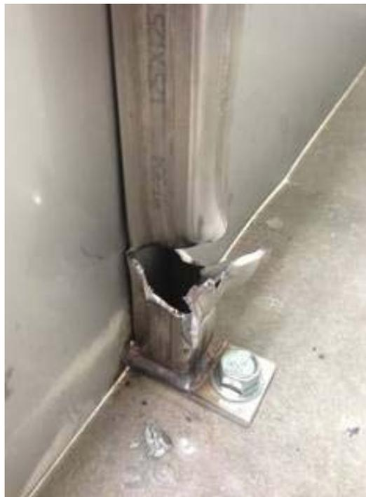
切断治具先端に取り付けるカメラにより、切断を確認する。
