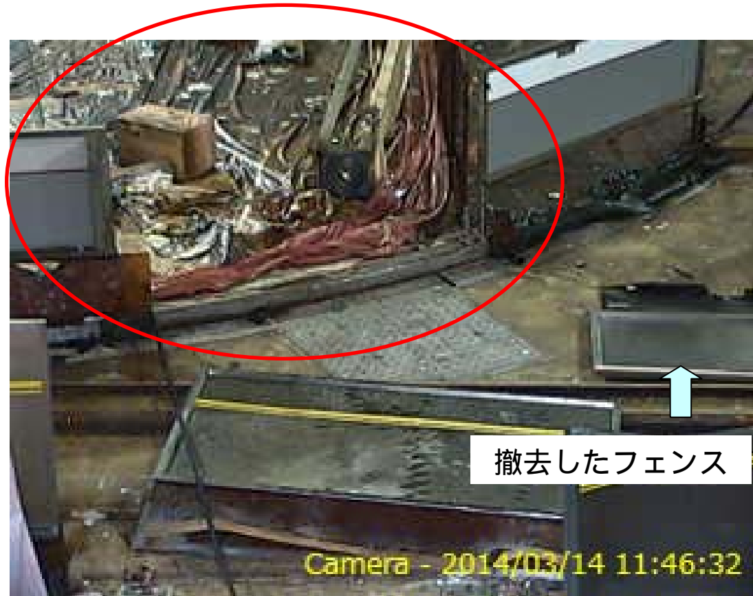
図4 フェンス撤去後
