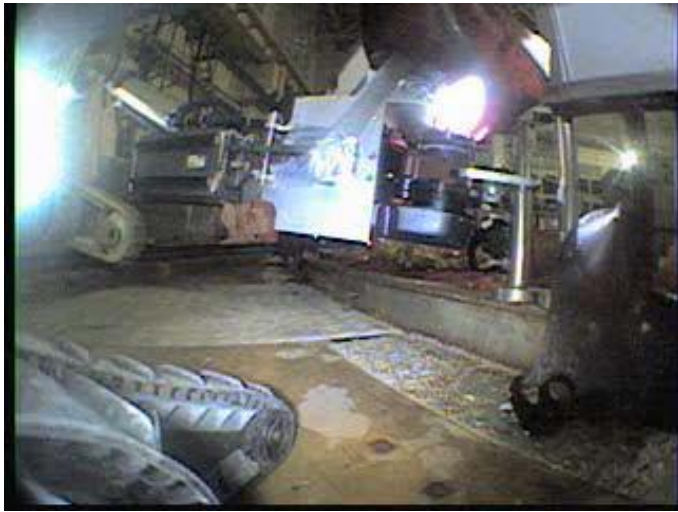
図2 フェンス脚部切断前
