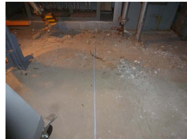
除染実証試験C/Dエリアガレキ状況
