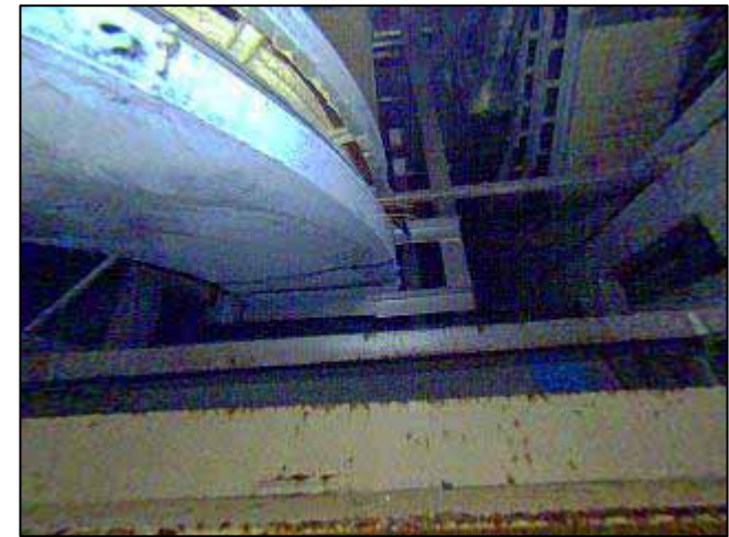
撮影箇所 壁面側上部(床上4.0m)
