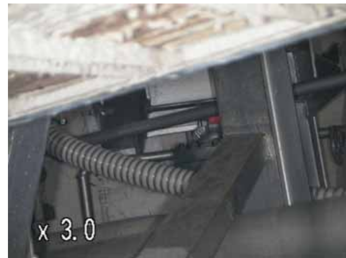
撮影箇所[1] P/A室上部(床上:4.7m)
