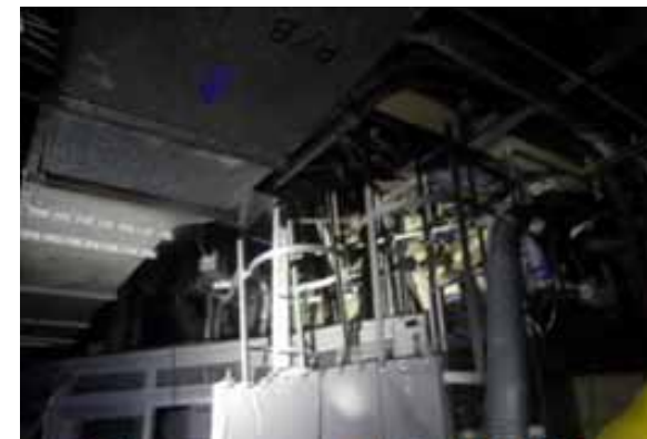
R/B 1階上部の状況 (2号機の例)
