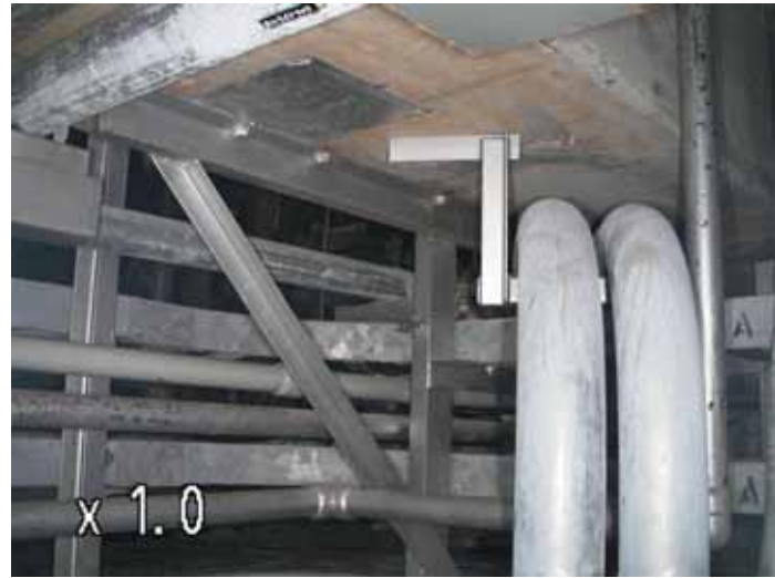
撮影箇所[2] P/A室上部(床上:5.6m)
