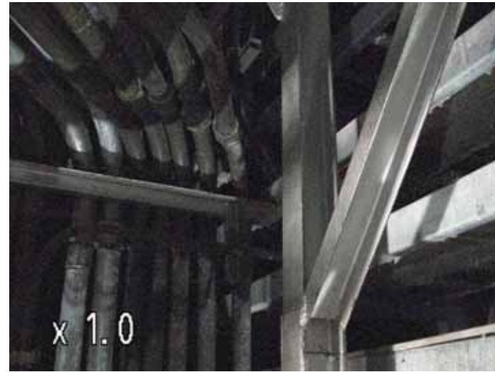
撮影箇所[1] P/A室上部(床上:4.4m)
