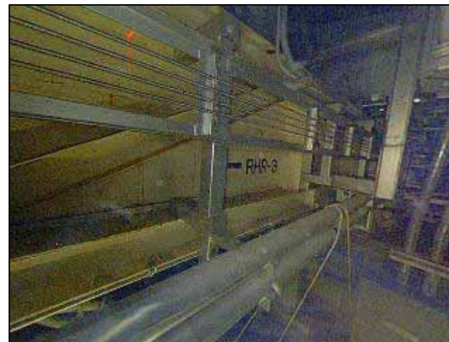
撮影箇所 壁面側(床上3.5m)
