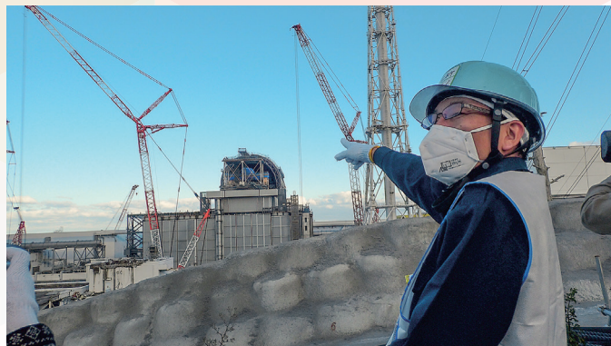
3号機燃料取り出し用カバー設置の状況を報道関係者にご説明されているところ 〔2017年11月21日撮影〕
