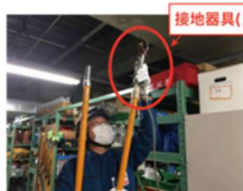
フック棒上部に 接地器具(上部)を付ける。
