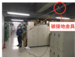
被接地金具に 接地器具(上部)を付ける。
