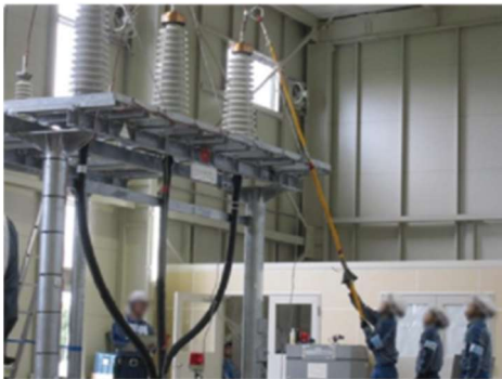
▲地上付近の設備に取り付ける様子
