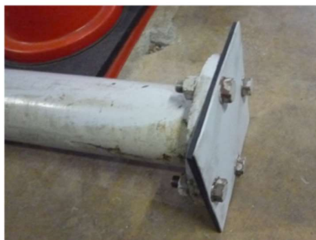
◀ 現在使用中の鉄板による仮蓋
