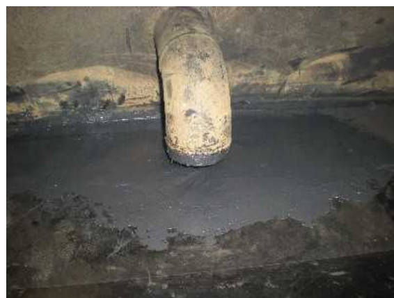
底板ドレン配管近傍
