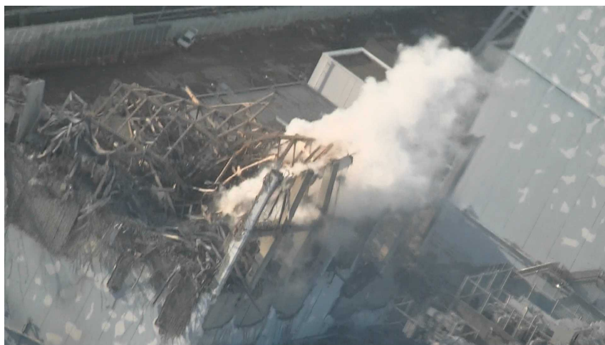
図 12 3号機空撮写真 (2011年3月16日撮影)
