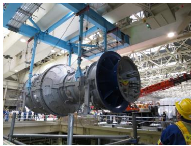
新しいガスタービン設備本体 の吊り上げ作業
