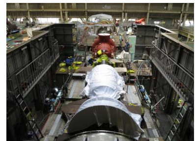
ガスタービン設備 分解作業
