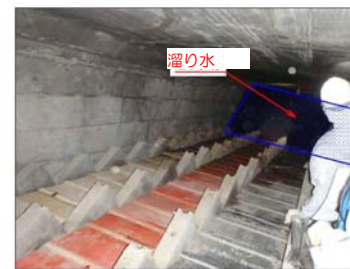
内部写真 (溜り水)
