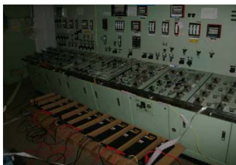
職員の通勤用乗用車のバッテリーを必要な計器につなぎ込み
