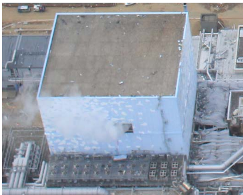
図 2号機ブローアウトパネルの開放状況
