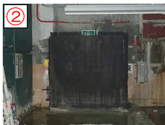
② 焼却-工作建屋間扉止水状況
