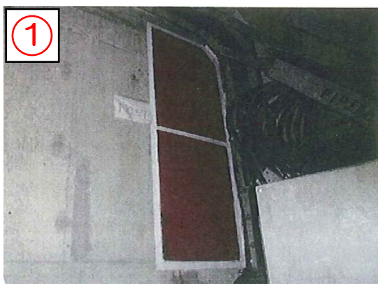
① 焼却建屋ケーブルトレイ部止水状況
