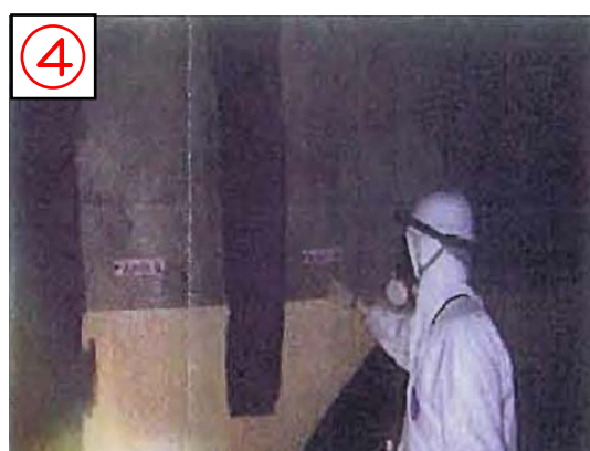
④ 工作建屋西壁補修状況
