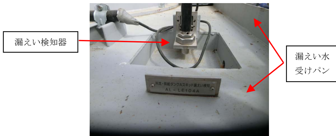
図6 漏えい検知機の設置状況 (一例)
