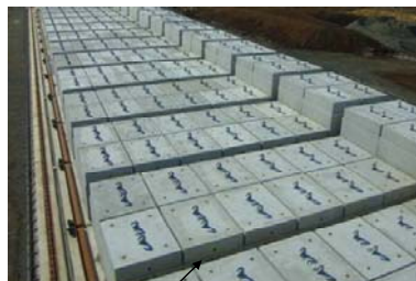
ボックスカルバート間通路
