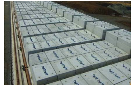
ボックスカルバート設置エリア
