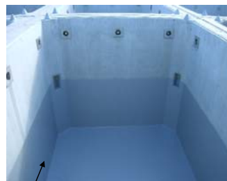
内面塗装 (内面塗装後)
