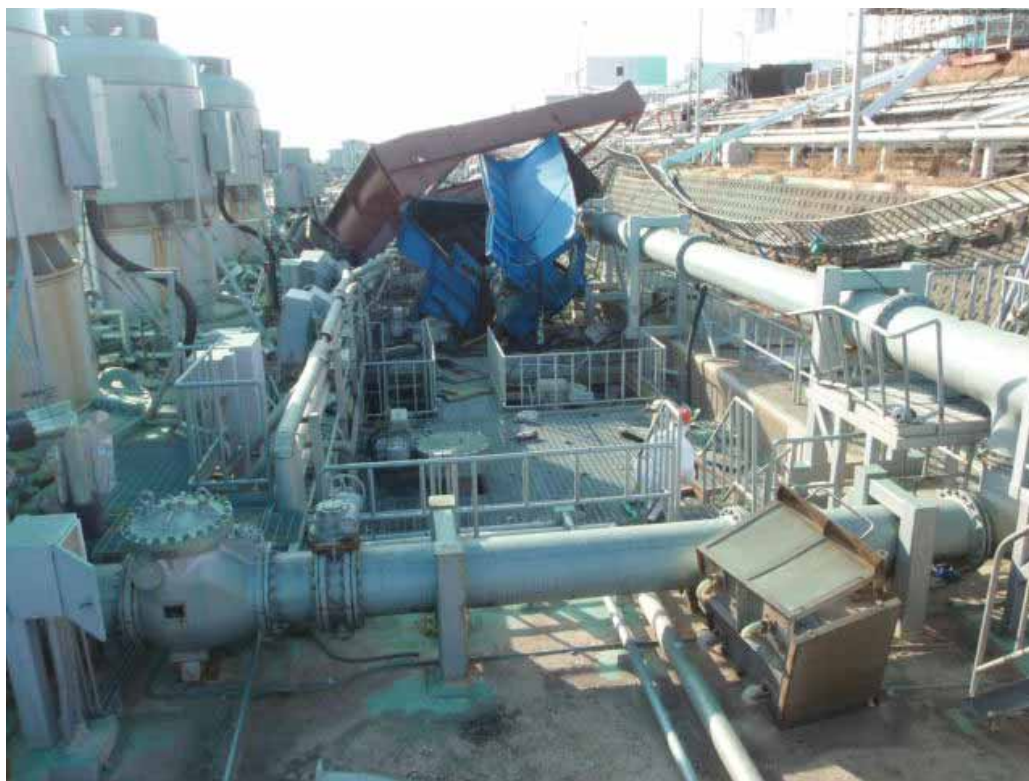
【 2号機ポンプ室循環水ポンプ吐出弁ピット全景】
