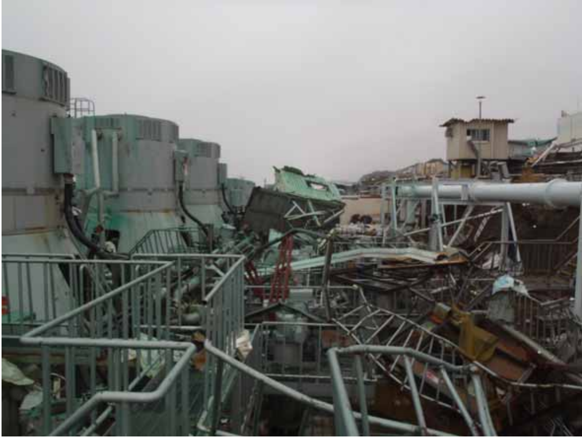
【 3号機ポンプ室循環水ポンプ吐出弁ピット全景】
