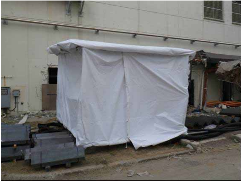
【屋根掛け設置完了】
