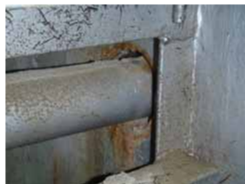
【ピット内貫通部近接】
