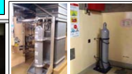
原子炉建屋地下1階 D/Wベント用空気ポンプ 予備ポンペ
