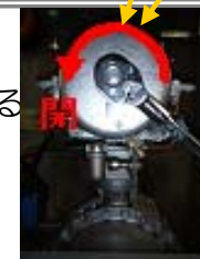
原子炉建屋地下1階 D/Wベント用空気ポンプ 予備ポンペ
