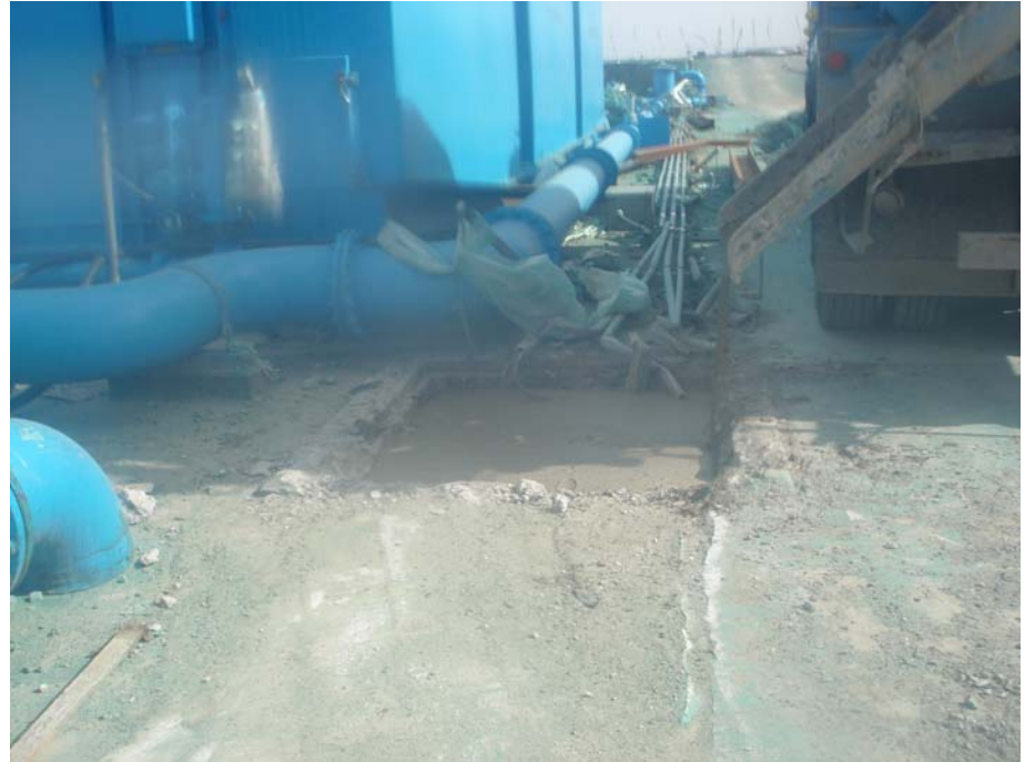
コンクリート打設の事例
