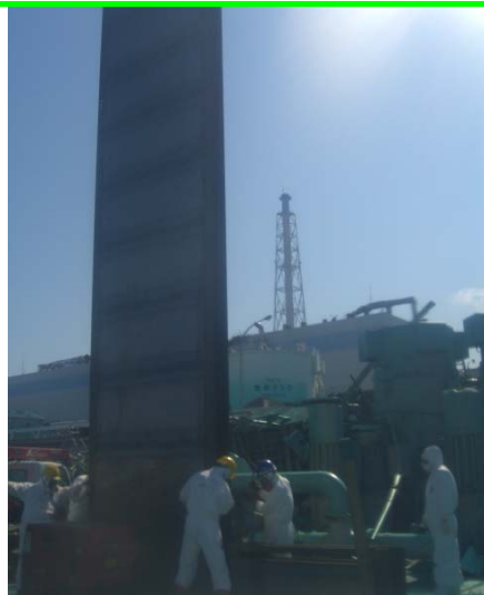
補機冷却用海水ポンプ室角落とし設置 [既実施]（2号機）（5/24完了）
