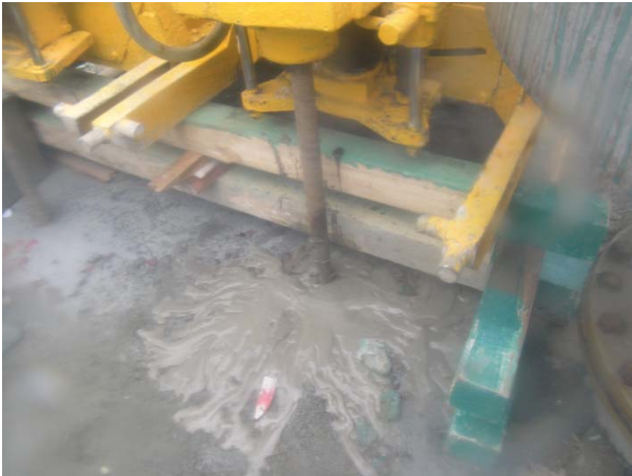
LW（水ガラス+モルタル）注入の事例
