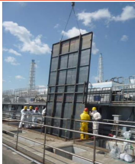
鉄板設置[既実施]（2号機） （4/15完了）
