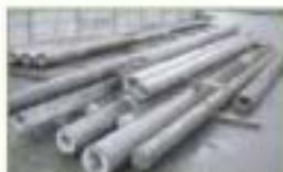
撤去したコンクリート柱は良品・不良品の選別をし、良品は再使用します。
