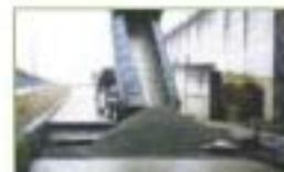
コンクリート部分は道路の路盤材に、鉄筋部分は鉄鋼原料としてリサイクルされます。
