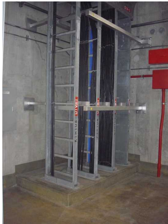
第2図 ケーブルトレイ床貫通部外観
