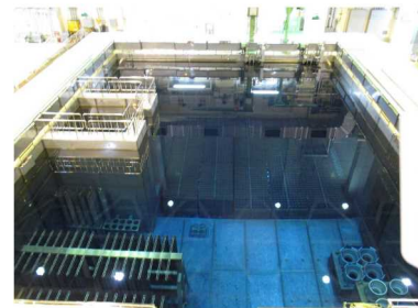
①使用済燃料貯蔵プール全体
