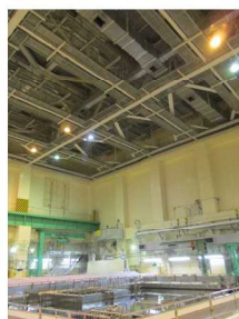
使用済燃料貯蔵プール天井
