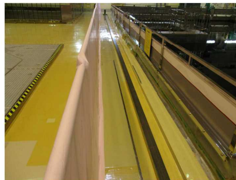
使用済燃料貯蔵プール周り(手摺り)
