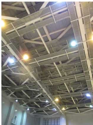
原子炉建屋 天井面
