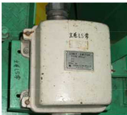
図 5.2.17 過巻防止用リミットスイッチ (主巻, 補巻上装置) (6 号炉の例)
