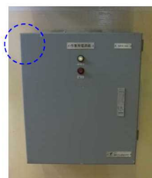
ボルトによる壁面固定
