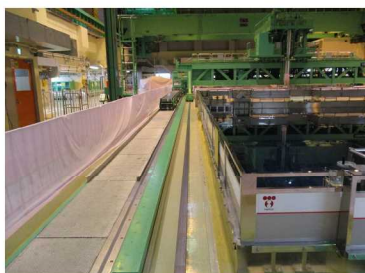
②使用済燃料貯蔵プール側面
