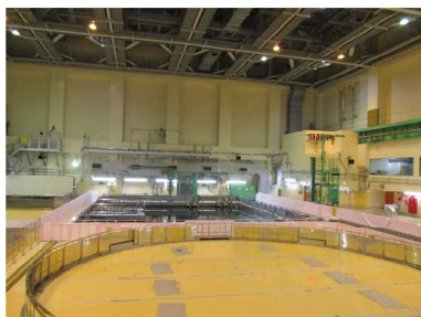
原子炉建屋内オペフロ全体
