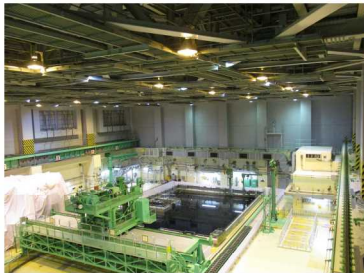
使用済燃料貯蔵プール天井
