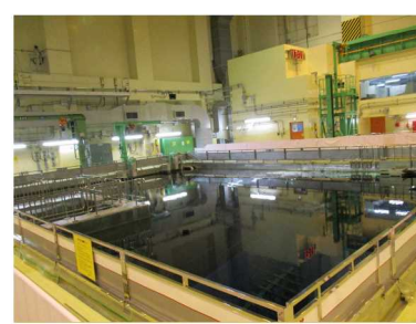
①使用済燃料貯蔵プール全体
