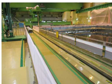
②使用済燃料貯蔵プール側面
