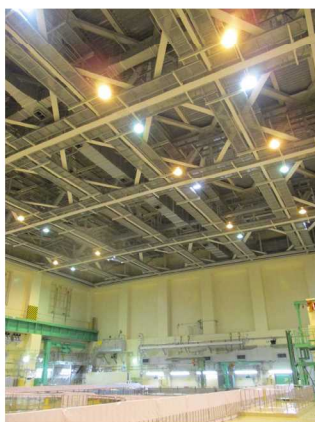
原子炉建屋 天井面
