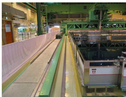
使用済燃料貯蔵プール周り(手摺り)
