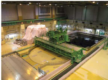
原子炉建屋内オペフロ全体
