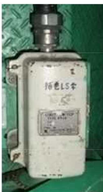
図 5.2.17 過巻防止用リミットスイッチ (主巻, 補巻上装置) (6 号炉の例)
