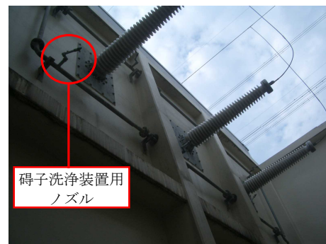
154kV 送電線（開閉所出口）
