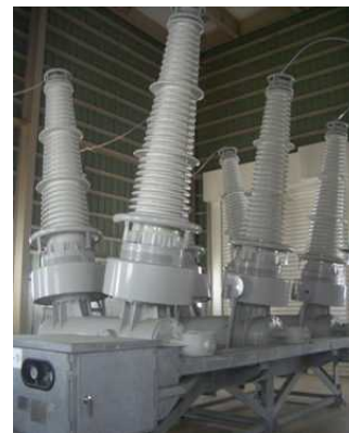
ガス遮断器（154kV）
