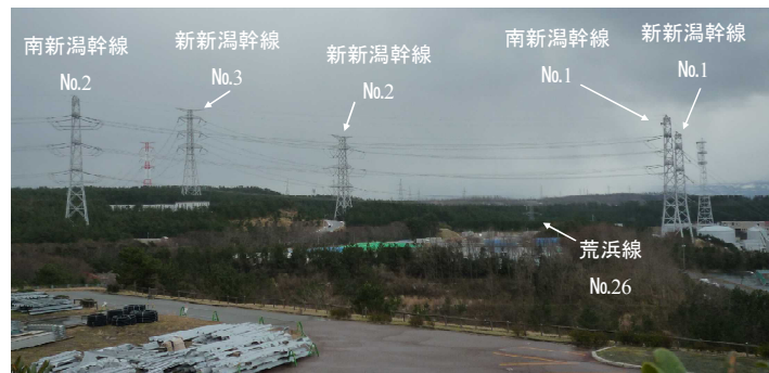
第2.4.1-2図 柏崎刈羽原子力発電所構内の送電線の近接箇所
