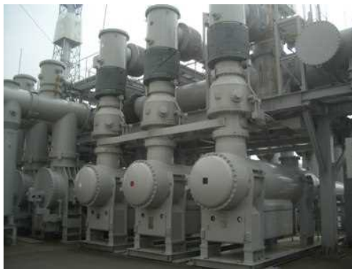
ガス絶縁開閉装置（500kV、66kV）
