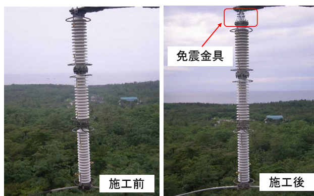
第2.4.4-5図 免震金具取付の施工状況
