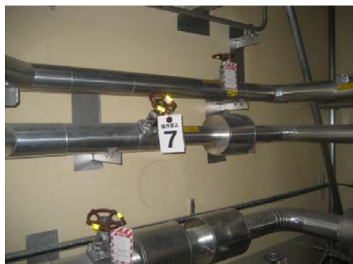
作業エリア（RHRポンプ室）
