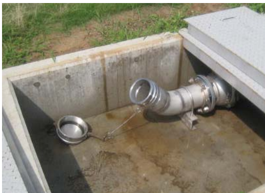
ホース接続部
