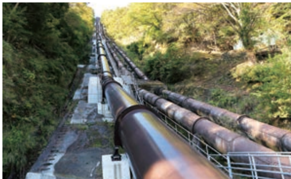
経年水力発電所のリパワリング工事により水圧鉄管を交換し発電出力の増強に対応
