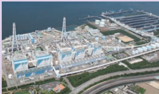
燃焼時にCO 2 が発生しないアンモニアの混焼実証を予定する愛知県の碧南火力発電所
