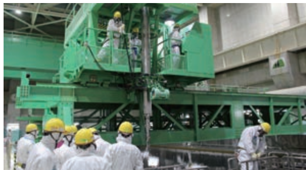
本年2月に3号機使用済燃料プールからの燃料取り出しが完了
