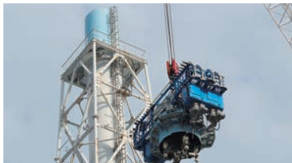
1・2号機排気筒の解体作業を実施
