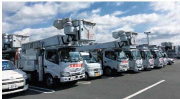
多くの企業等の協力を得て停電復旧作業を実施
