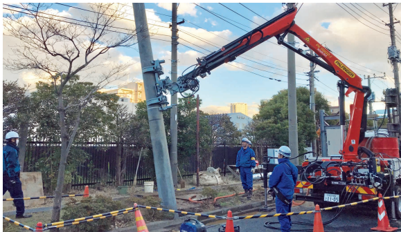
業務手順や工法、機材の見直しなどの一括改善により電柱建替工事の作業時間を大幅に短縮
