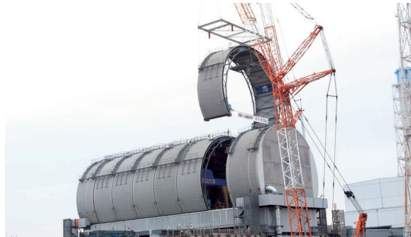
本年2月までに3号機原子炉建屋上部への燃料取扱機及びカバーの設置作業が完了
