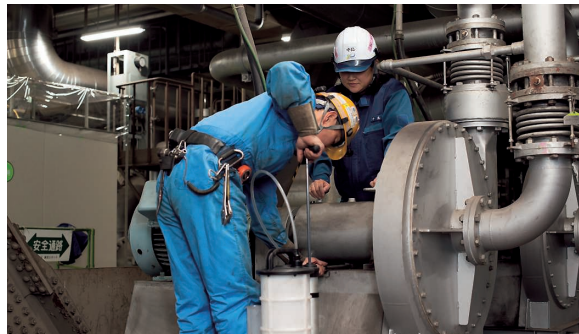
手動吸引ポンプの導入等により日常保守等の作業の所要時間を大幅に短縮
