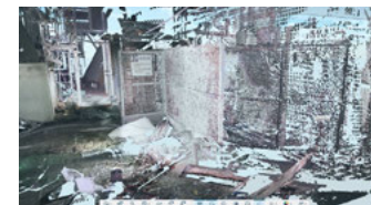
3号機の原子炉建屋内調査
