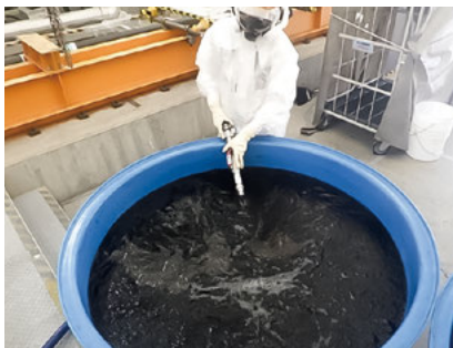
吸着材の交換作業
