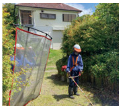
除草作業 (帰還困難区域内)
