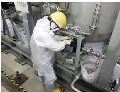
吸着材の逆洗作業
