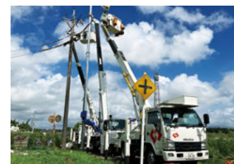
電柱元位置建替車両。東京電力PGが開発。本特許は他社にライセンスし、幅広く活用。
