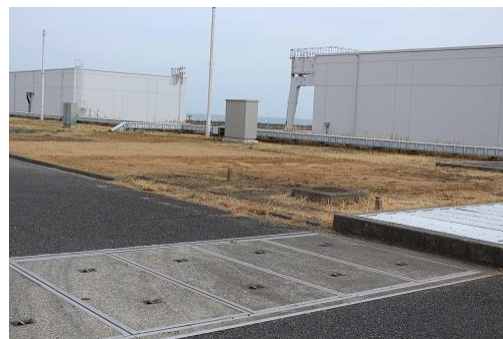
解体撤去完了 (3月29日撮影)
