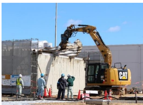
重機による解体撤去 (2月25日撮影)
