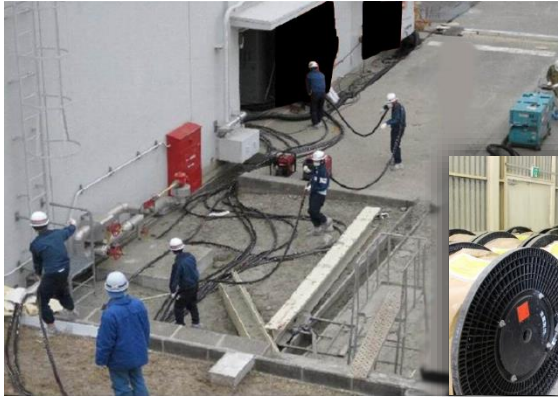
動力用ケーブルの布設（震災時）
