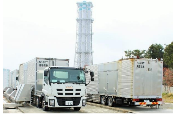
ガスタービン発電機車（点検時に備え2台配備）
