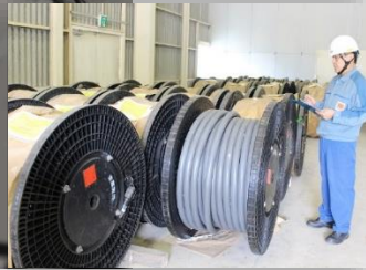
動力用ケーブルの管理
