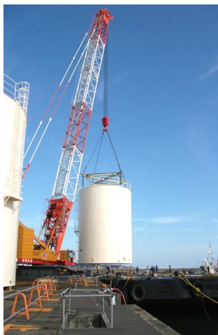
大型クレーンによるタンクの積み上げ
